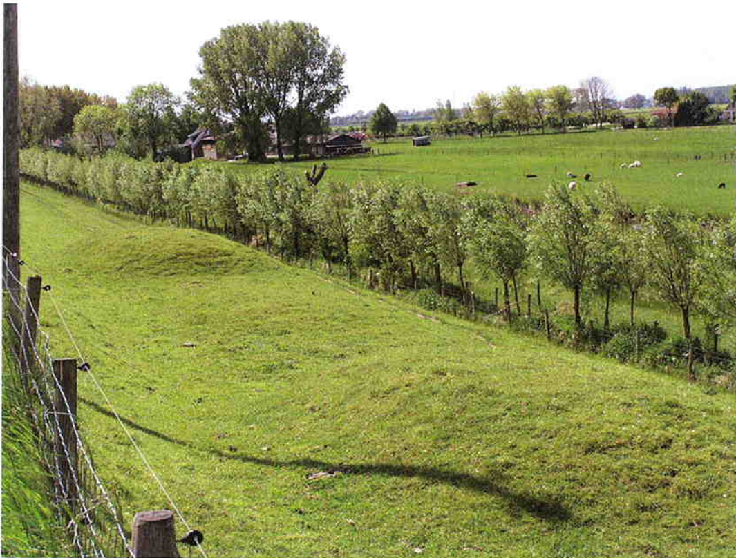
Figuur 14: Huidige situatie grondwerk middelste geschutsbanket aan de noordelijke Diefdijk
