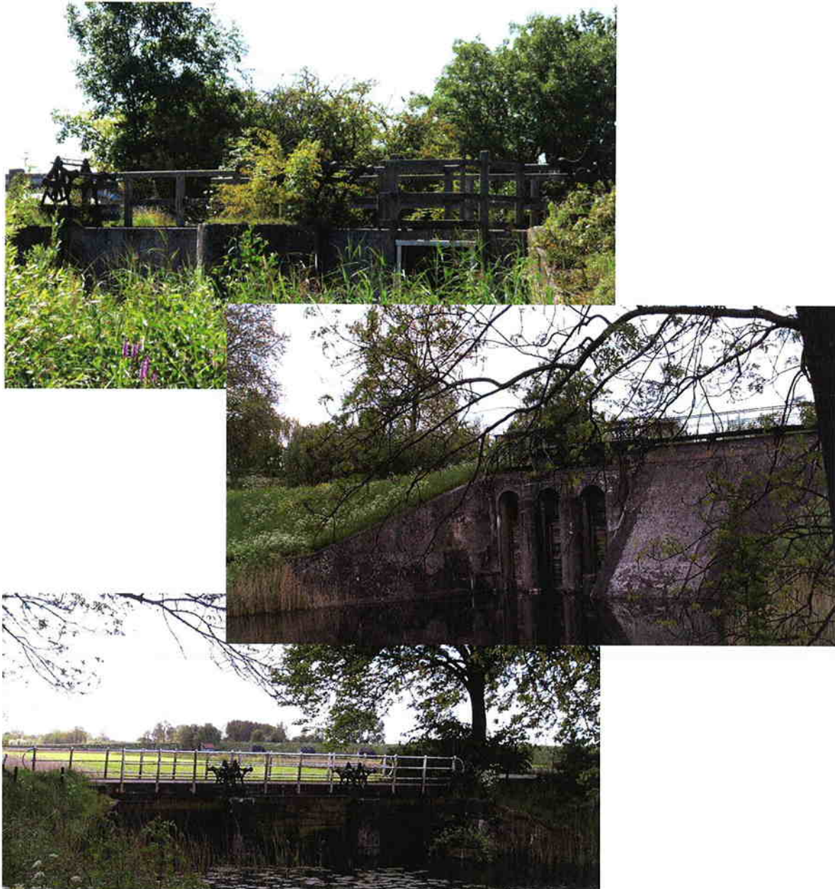
Figuur 12: respectievelijk Inundatiesluis bij de Lek, de Beersluis en de Schotbalkenstuw
