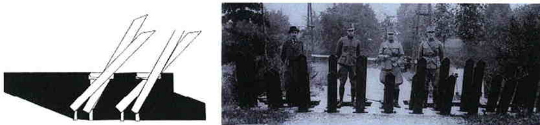
Figuur 7: Constructie en foto tankversperring (Bron: "In de IJn van de Versteende Ridders")
