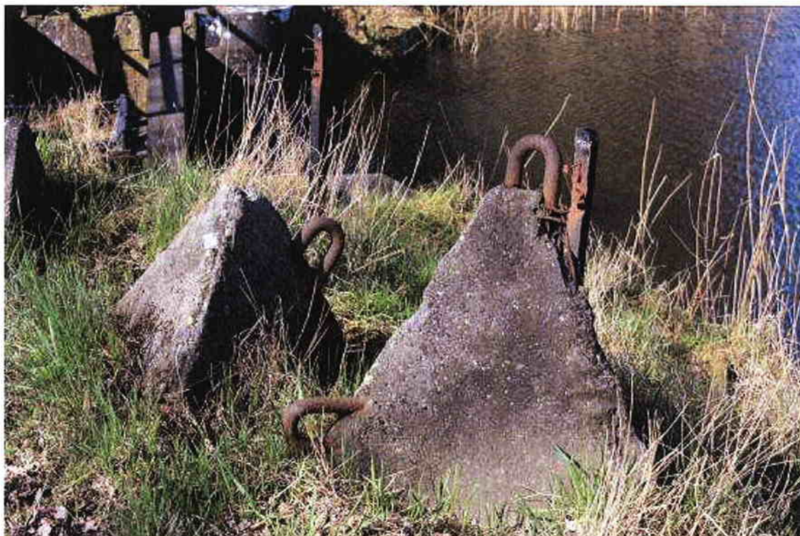
Figuur 15: foto van onderdelen van een tripods versperring bij Fort Everdingen
